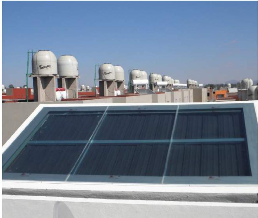
***El Calentador Solar Modelo DCO es un sistema diseñado para proporcionar agua caliente a una temperatura promedio de 50°C, siendo enfocado principalmente para viviendas de interés social y desarrollos inmobiliarios.***
